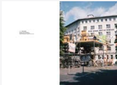
Hier entsteht Rosa-Luxemburg-Platz Juli 2003
